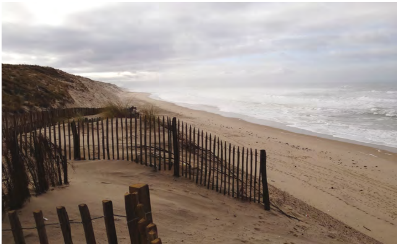
Figure 30 : Erosion de la dune dans le secteur de Carcans-Plage (Creocean, 2014)
