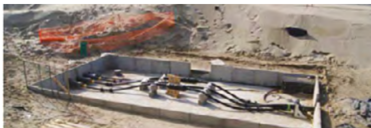
Figure 14 : Chambre de jonction d'atterrage avant comblement
