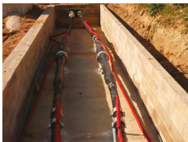
Figure 10 : Schéma et illustration de chambre de jonction
